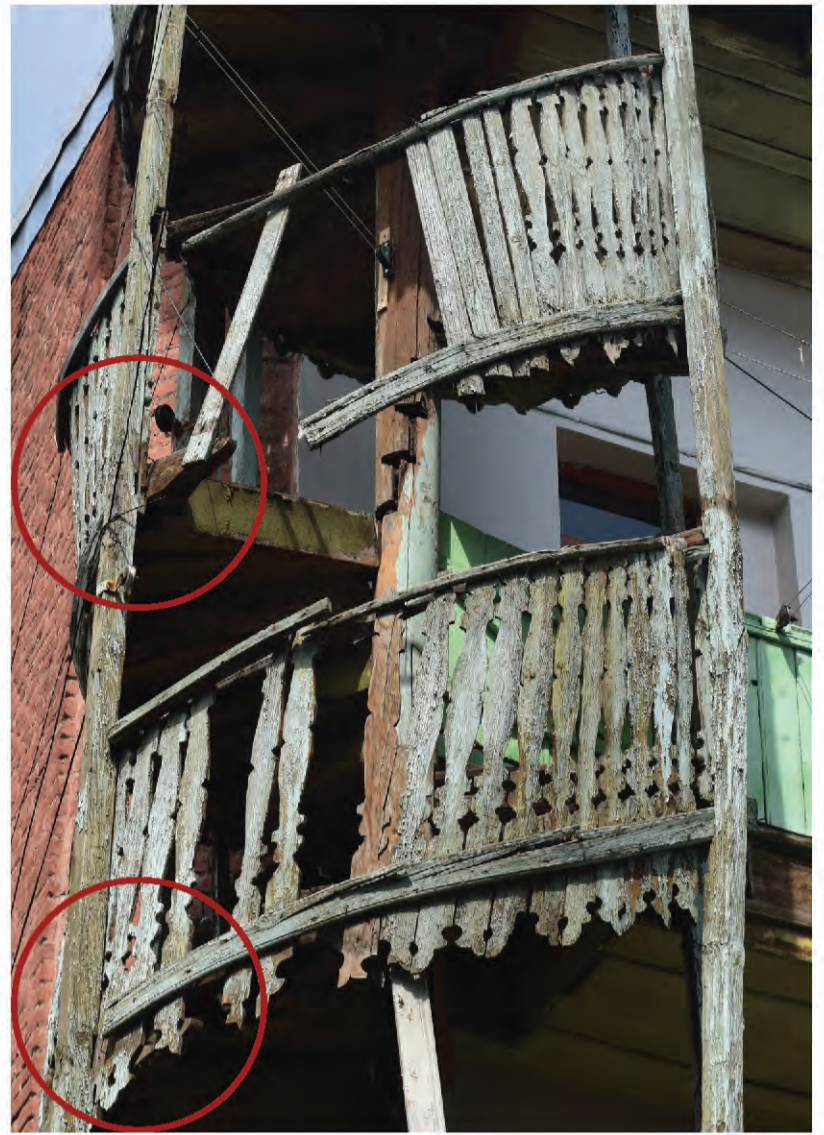
მოაჯირის შემკრავი დეტალი უწყვეტად უნდა მოეწყოს a-დან c გარე სვეტამდე
